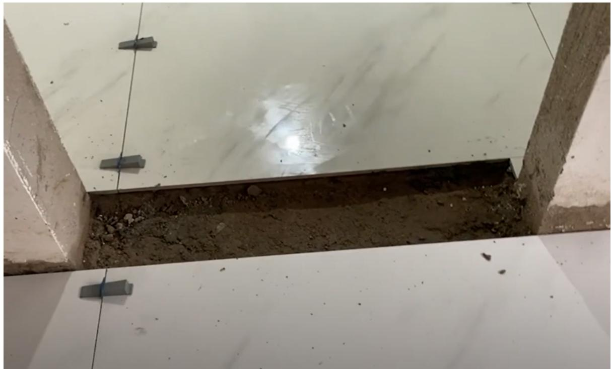
Ela também é usada – e neste caso, **obrigatoriamente**, – nos ambientes em que há desnível, na passagem de um quarto para uma varanda ou banheiro (que são áreas molhadas), o desnível é de 2cm, no mínimo, na medida da soleira. Se é feita de granito, deve vir com acabamento adequado, pois ficará aparente, e a marmoraria deve ser informada sobre isso.
