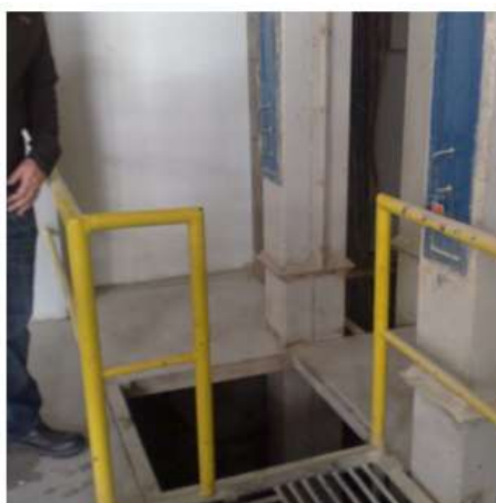
Abertura no piso, sem proteção
