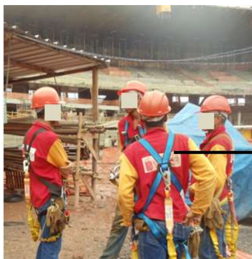
Capacete para proteção contra impactos de objetos sobre o crânio e protetor auricular para proteção do sistema auditivo contra ruídos excessivos
