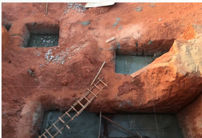
Sapatas preparadas com uma camada de concreto para receber o radier.
