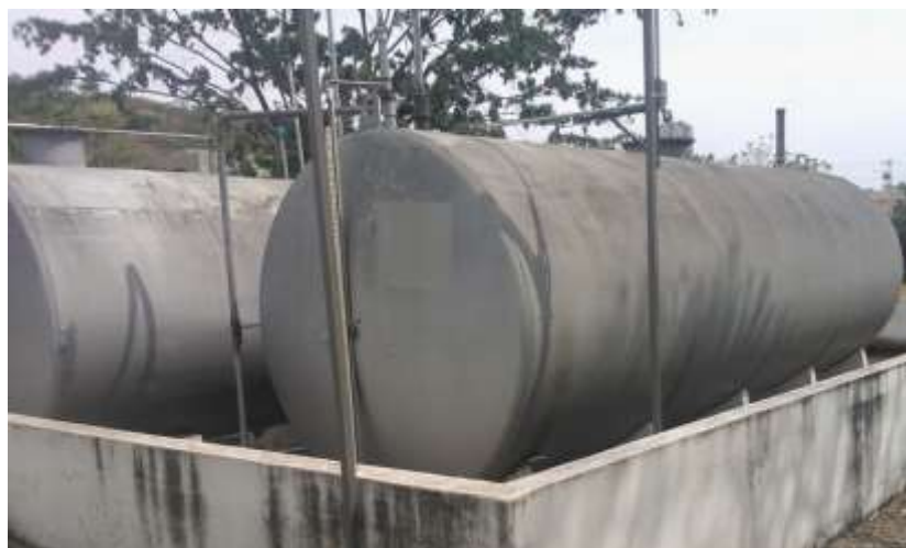
Tanques de armazenamento de combustíveis (10.000 litros) – Instalação Classe II
