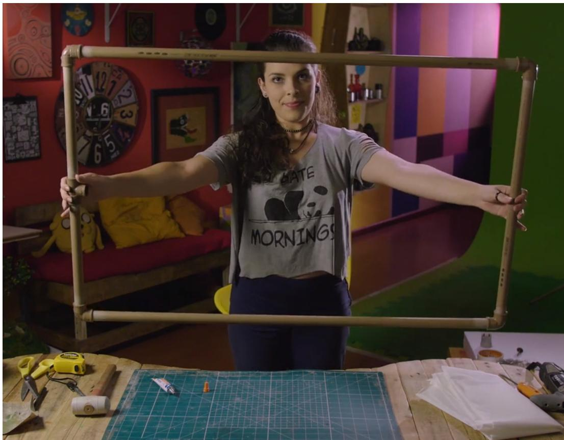
Nesta altura, você já pode pintar toda a estrutura utilizando o spray de tinta. Depois que a tinta secar, passe fita dupla-face em toda a superfície dos canos.
