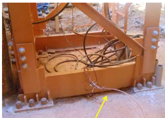
Cabo de aterramento da torre de grua
