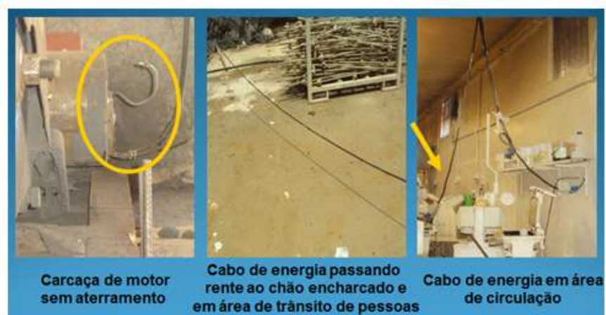
Instalações elétricas – irregulares
