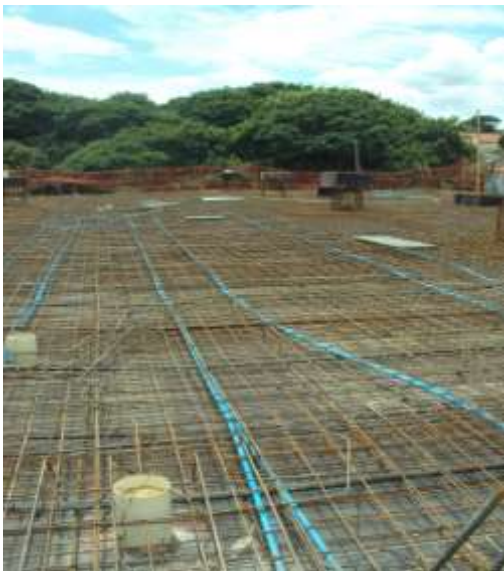
Armações sem prancha, o que dificulta a circulação de trabalhadores
