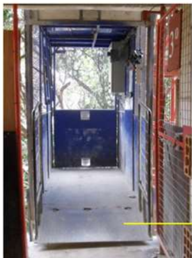
Detalhe do interior da cabine do elevador cremalheira: a rampa de acesso encontra-se abaixada
