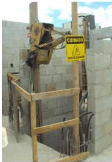
Guincho de coluna instalado no poço do elevador. Proteção contra queda de altura precaríssima.
