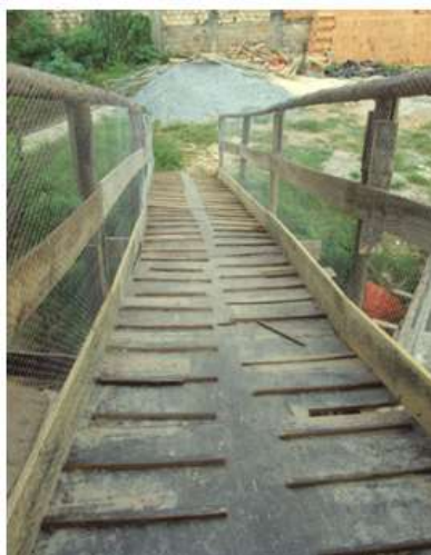
Rampa: Inclinação > 6° Peças transversais: espaçadas máx 0,40m
