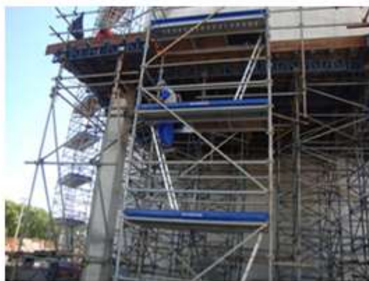
Andaime simplesmente apoiado, com escada incorporada à própria estrutura
