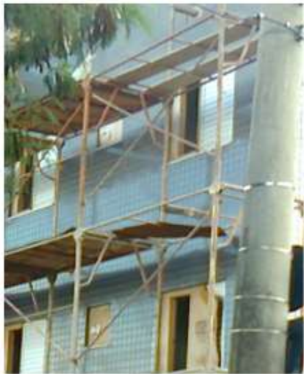
Andaimes com piso sem forração completa.
