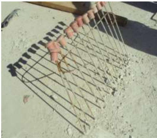
Vergalhões com extremidades protegidas
