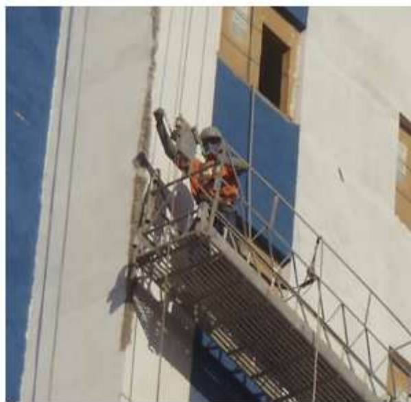
Andaime suspenso com acionamento manual
