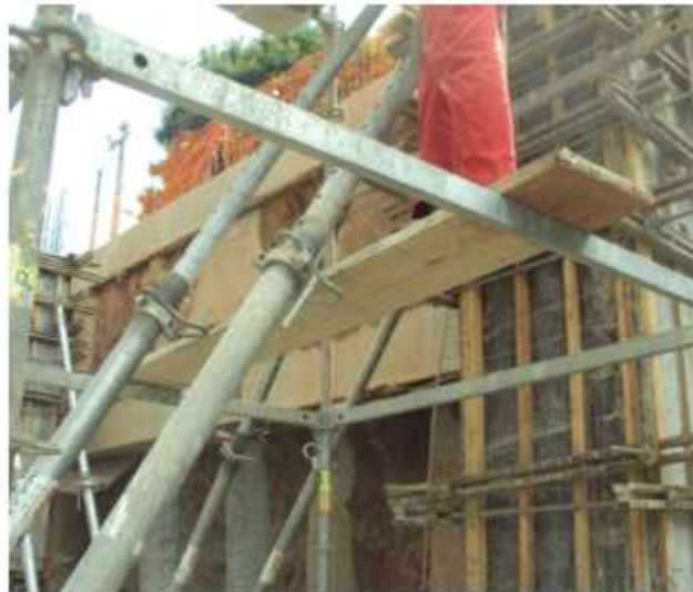
Andaimes com piso sem forração completa.
