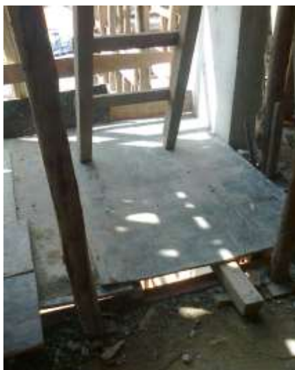
Situação irregular: escada portátil sobre estrutura sem resistência
