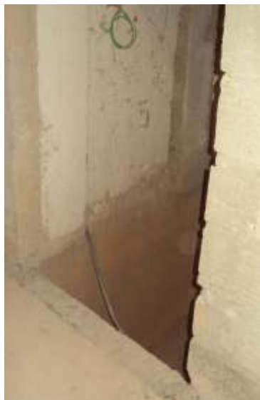
Vãos de acesso às caixas dos elevadores sem proteção coletiva contra queda de trabalhadores e de materiais
