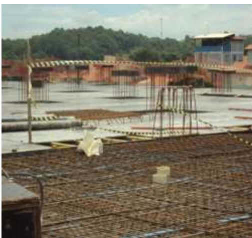
Cobertura parcial das armações utilizando pranchas.
