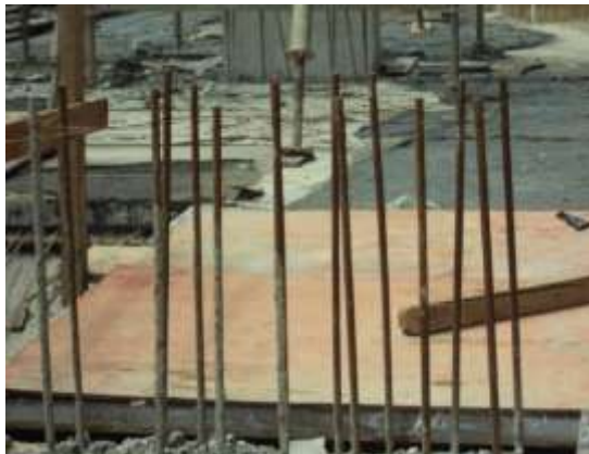
Vergalhões com risco de corte (extremidades desprotegidas)
