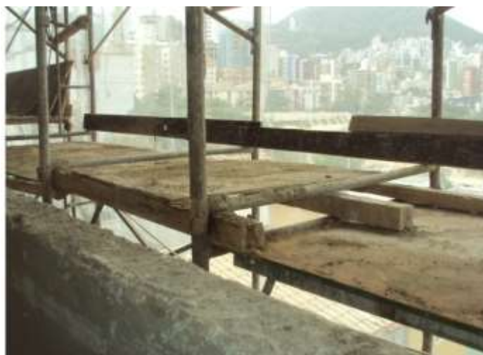
Andaime simplesmente apoiado com piso desnivelado (vou nem falar da falta de proteção contra queda de altura!)
