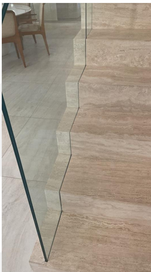
Figura 20 – corrimão de escada engastado com vidro laminado
