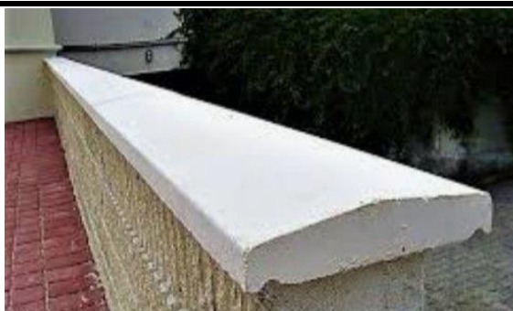
Figura 1 - Chapim de platibanda premoldado pintado na cor branca
